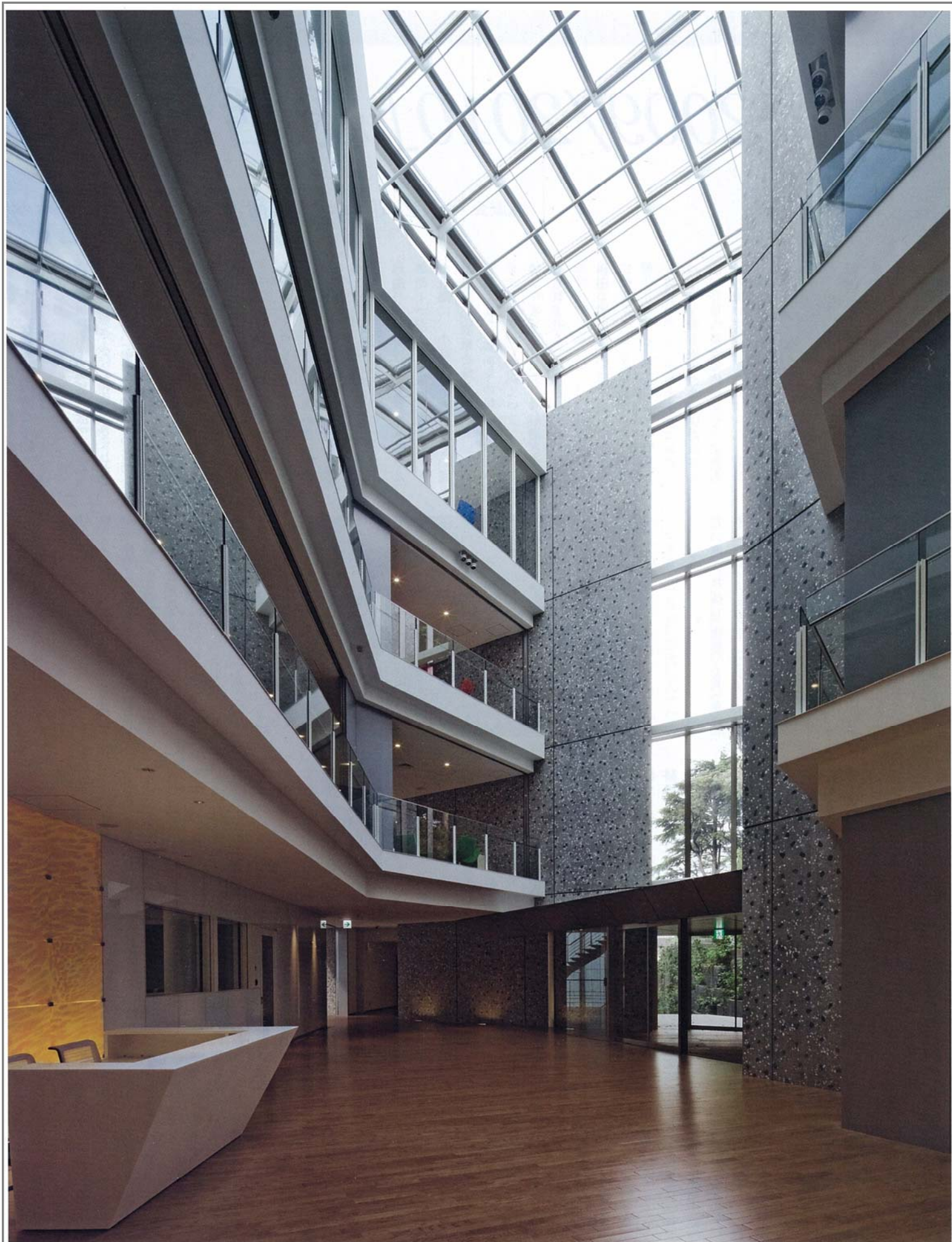
エントランス・ホール。トップライトのあるアトリウム。平行でない東西両ウィングのPCa版で仕上げられた小口面がインテリアに現れている
